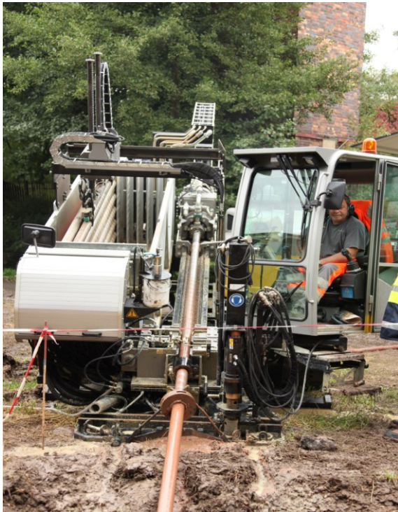
Bohranlage während des Ziehvorganges an der Startgrube
