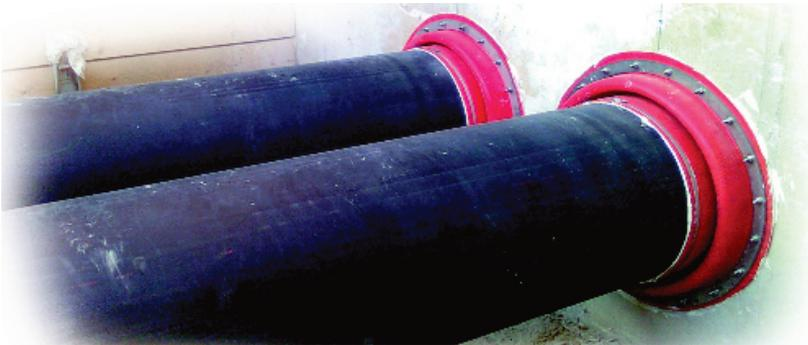
Abbildung 93, Beispiel einer Schachteinführung mit Compenseal vor der Wand
