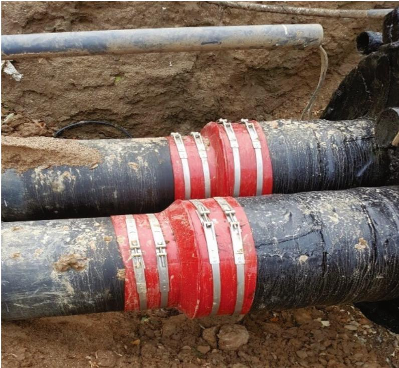
Abbildung 95, Abdichtung Hülrohr zum Mantelrohr mit Gelenkbolzenband
