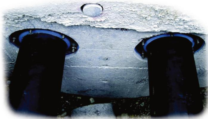
Abbildung 89, Beispiel Hausanschluss mit Ringraumdichtungen
