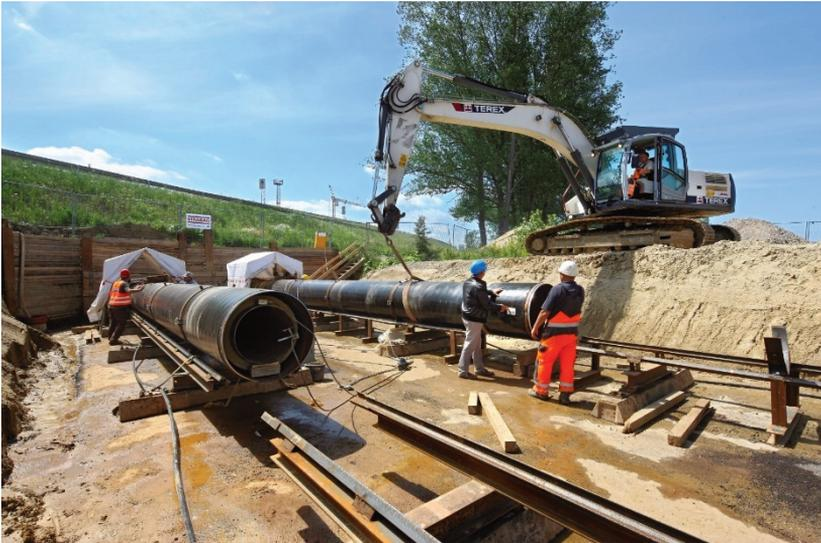
Abbildung 96, Verlegung von Stahlmantelrohren
