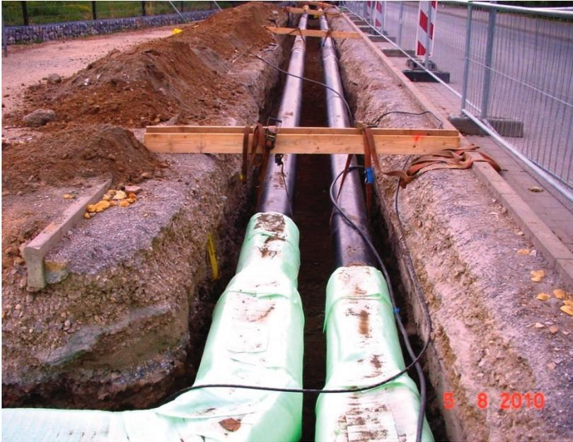
Abbildung 83, Mehrlagige, ovalförmige Polsterung eines L-Schenkel mit Vollumhüllung
