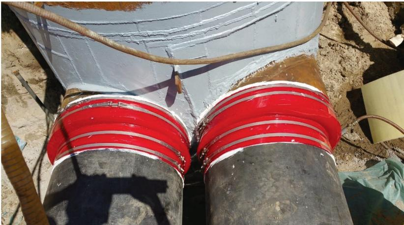
Abbildung 94, Beispiel einer KMR-Bauwerkseinführung
