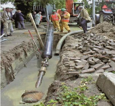
**Rohrspule mit flexiblen Rohr**
